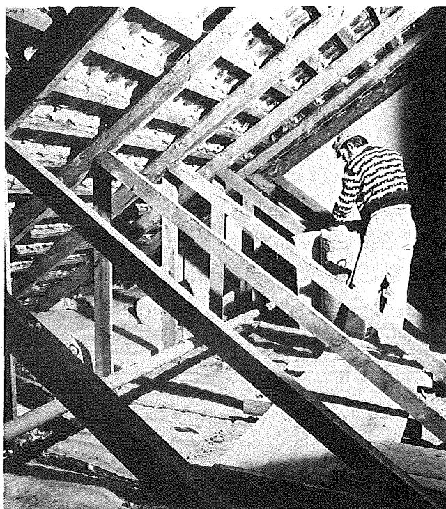
Loftet isoleres med 150 mm mineraluld.
