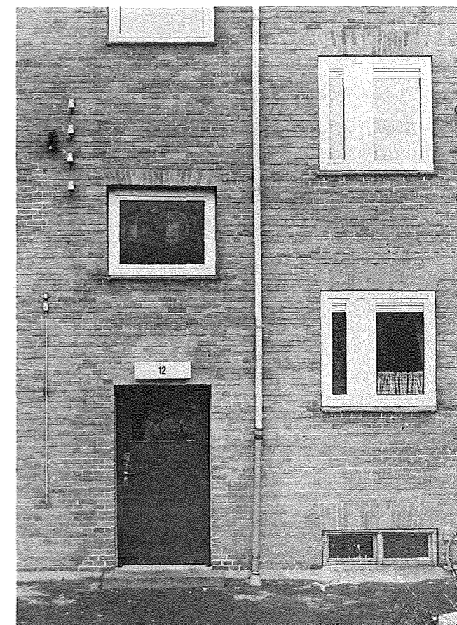
Kunststofvinduerne i indgangsfacaden.
