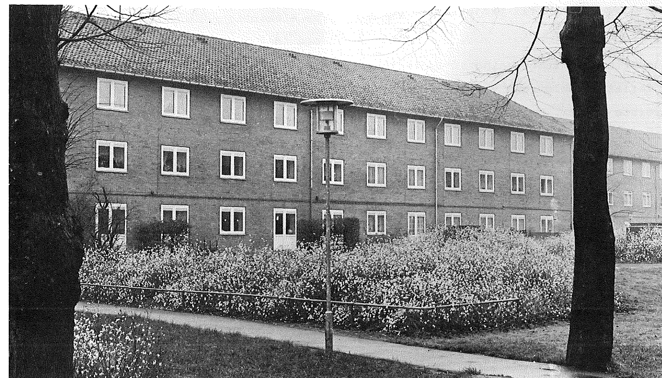
Havefacaden efter afsluttet vinduesudskiftning.
