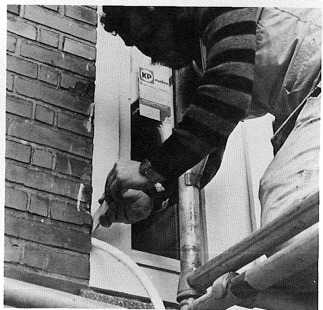
Bundstøpning foretages fra udvendig side.
