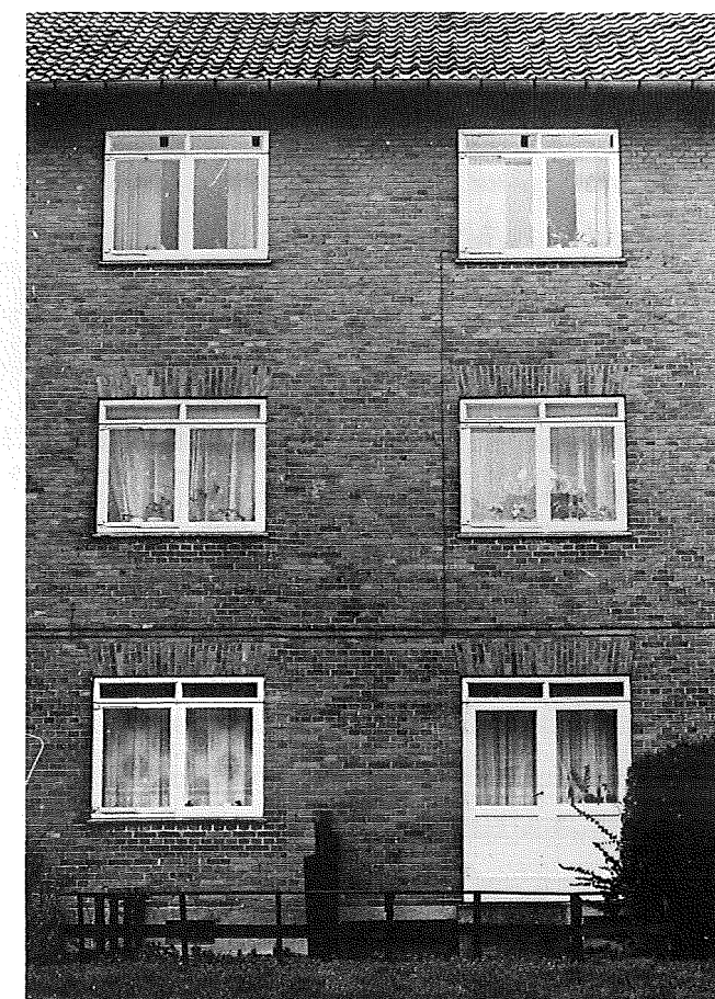
Udsnit af oprindelig havefacade.
