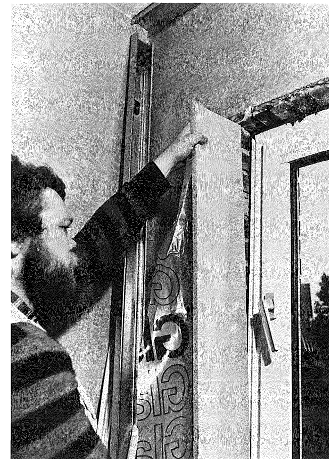
Montage af lysningspanel.
