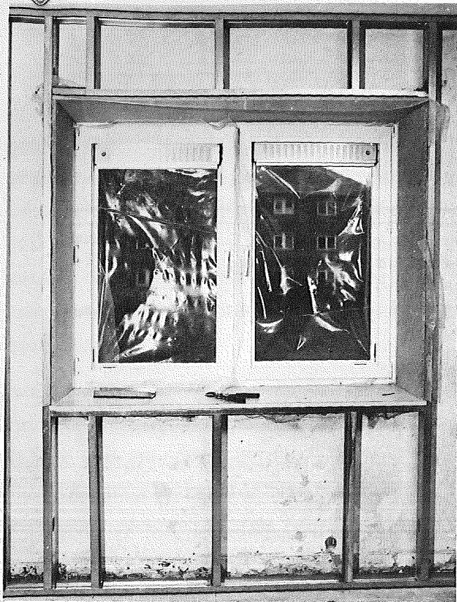
Skeletvæg klar til isolering.
