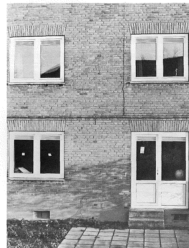
Kunststofvinduerne i havefacaden.
