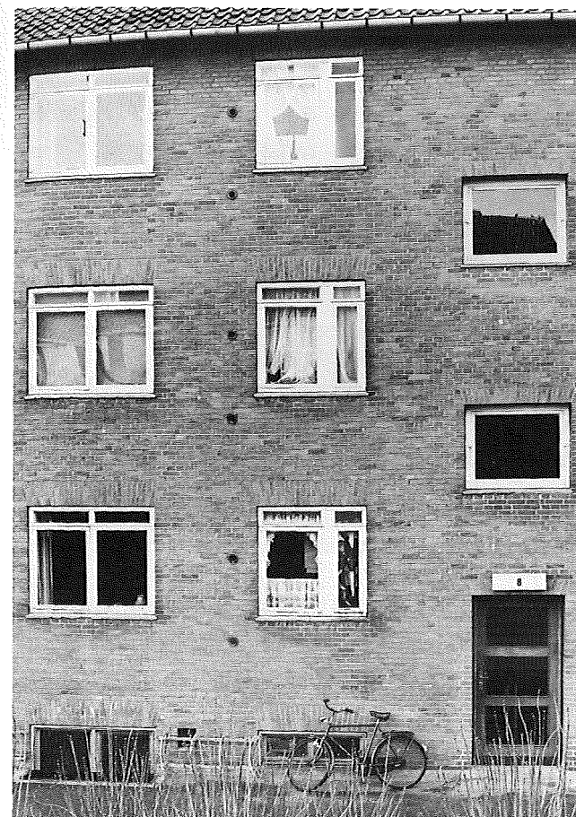
Udsnit af oprindelig indgangsfacade.
