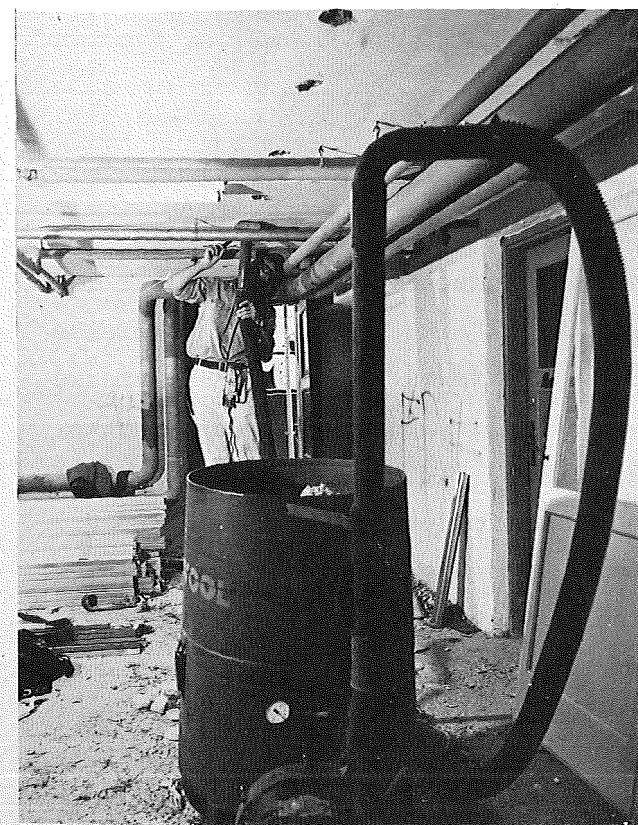
Indblæsning af granuleret mineraluld i træbjælkelag mod kælder.
