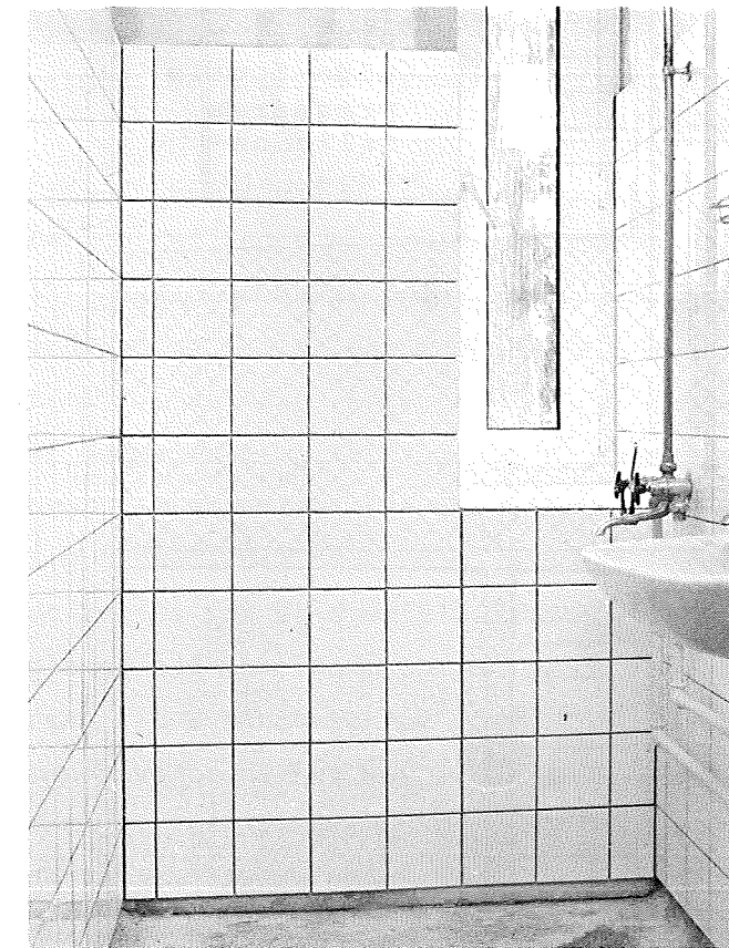
Færdigisoleret ydervæg i badeværelse. Flisestykker mod gulv endnu ikke anbragt.
