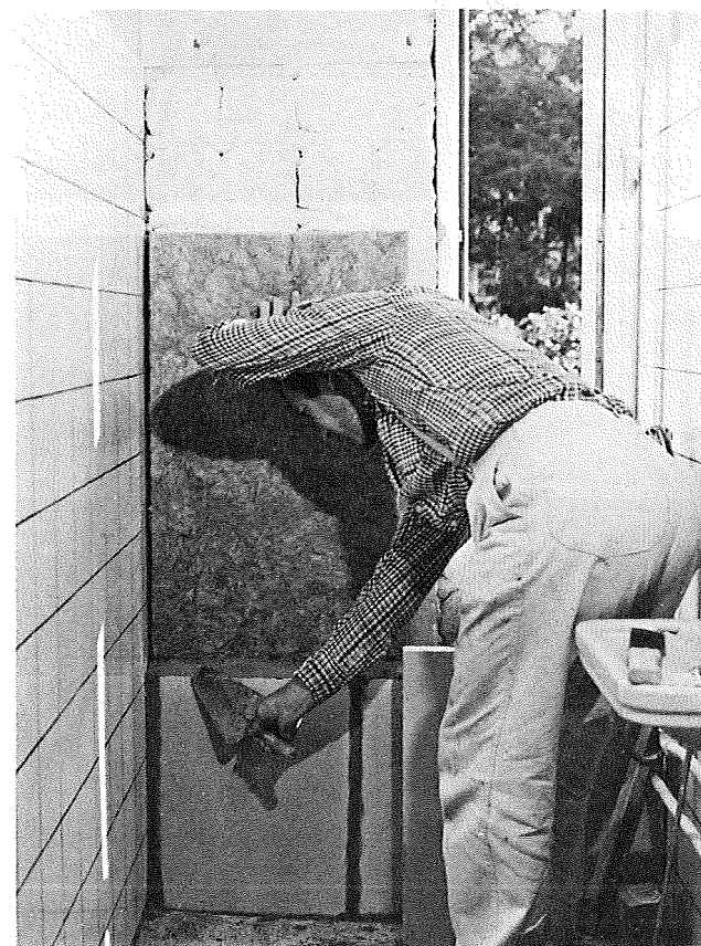
Opmuring af 50 mm letbetonvæg.
