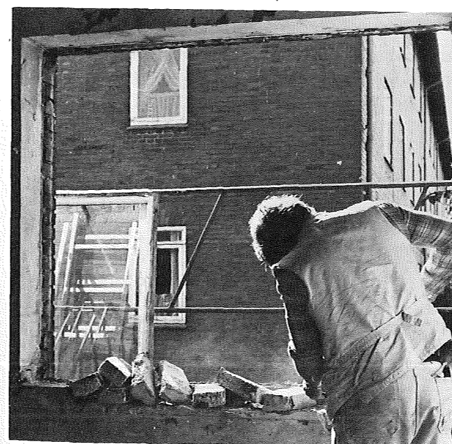
Øverste skifte klinkerbetonsten fjernes.
